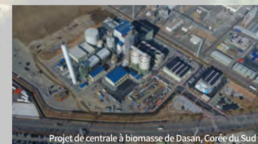
Projet de centrale à biomasse de Dasan, Corée du Sud
